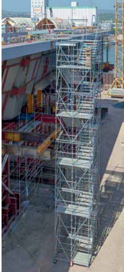
Üst: Temel erişim ve kaçış yolu olarak ve köprü inşaat şantiyesinde hacimli iskeleye entegre inşaat merdiven kulesi. Alt: Bireysel ve bağımsız merdiven kuleleri (Allround modüler merdiven kulesi ve inşaat merdiven kulesi 200).
