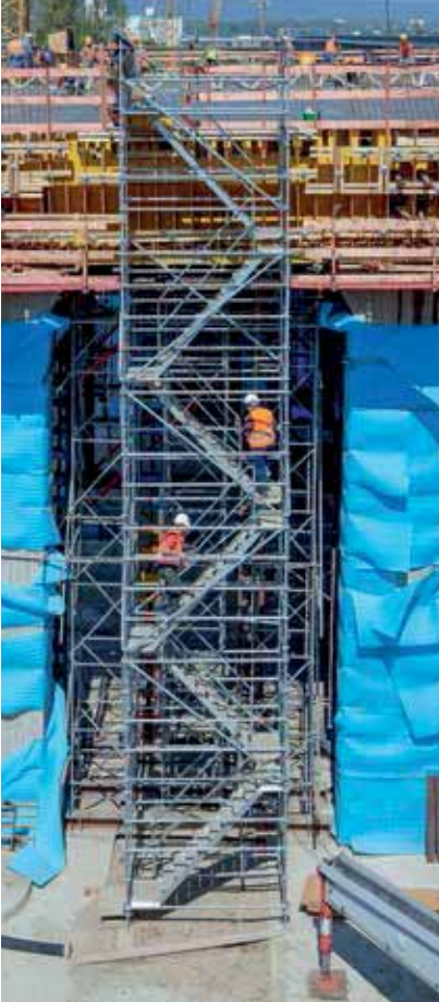
Üst: Temel erişim ve kaçış yolu olarak ve köprü inşaat şantiyesinde hacimli iskeleye entegre inşaat merdiven kulesi. Alt: Bireysel ve bağımsız merdiven kuleleri (Allround modüler merdiven kulesi ve inşaat merdiven kulesi 200).
